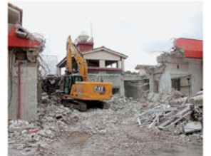
解体工事中(6月12日)
