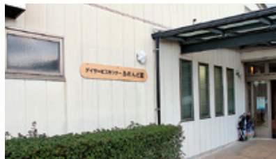
いずみの園 デイサービスセンター ふれんど館
