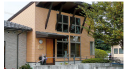
いずみの園 デイサービスセンター ふれあい館
